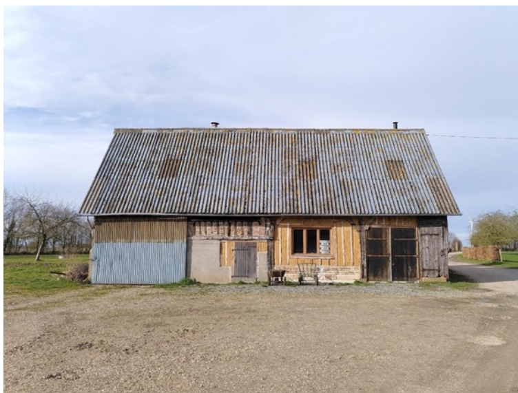
Ancien cellier transformé en boulangerie et chaudière bois
