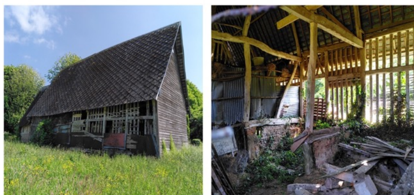
Une grange historique abandonnée sur un site secondaire récupéré lors d'un agrandissement (photo : GN)
